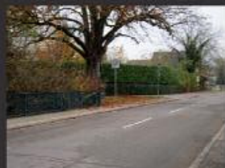
Mai Mühlbachbrücke (Umkircher Str. Richtung Umkirch)
